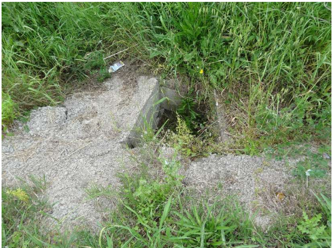
Figura 4. Tombino di convogliamento delle acque del bacino e loro sottopassa al corpo stradale.
